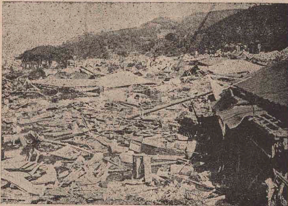
Vederea unui oraș japonez după cutremurul de pământ. Totul e dărâmat și distrus.
