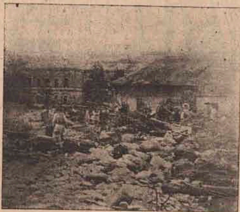
Vedere din strada Grănicerilor. Cursul nou al râului. Mormane de pietri, scânduri și rădăcini înaintea liceului „Gh. Coșbuc” și în dosul casei D-lui profesor Păcurariu. Aici s'au găsit cele mai mult cadavre, îngropate sub grămezi.
