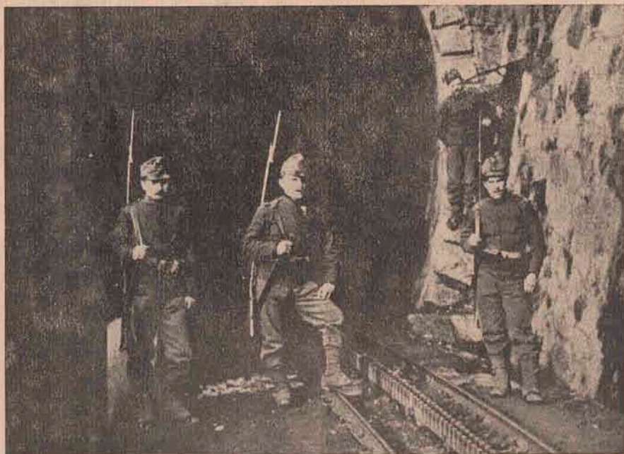
Paza unui tunel. Toate podurile drumurilor de fer, ba și a drumurilor celorlalte, mai ales în părțile pe unde se știe că are de trecut armată, — sunt așa păzite de soldați înarmați. Tot așa tunelele prin cari trec căile ferate, — cum se vede și în chipul de sus.
