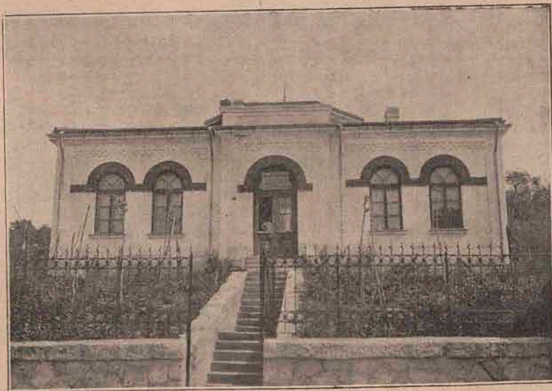
Vedere din Turtucaia: Baia turcă , o instalație modernă și higienică.
